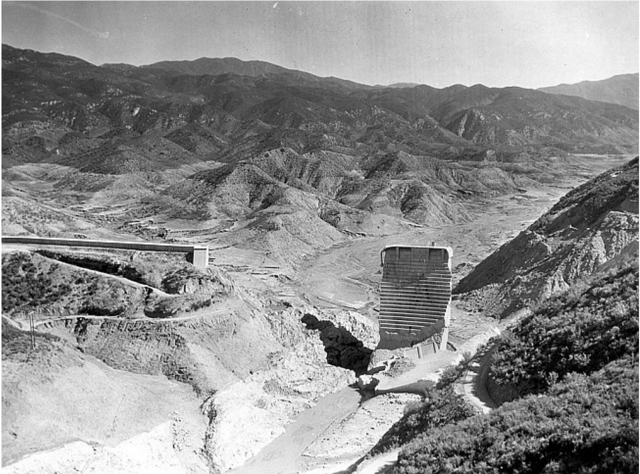
Überreste des St. Francis-Damms (1928)
